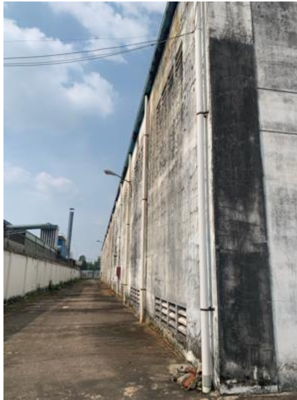
Hình 3.1: Hình ảnh đường ống thu gom nước mưa trên mái
