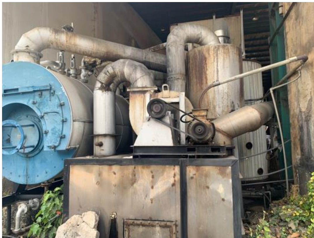
Hình 3.6: Hệ thống xử lý khí thải lò hơi 1,5 tấn/giờ hiện hữu tại Nhà máy
