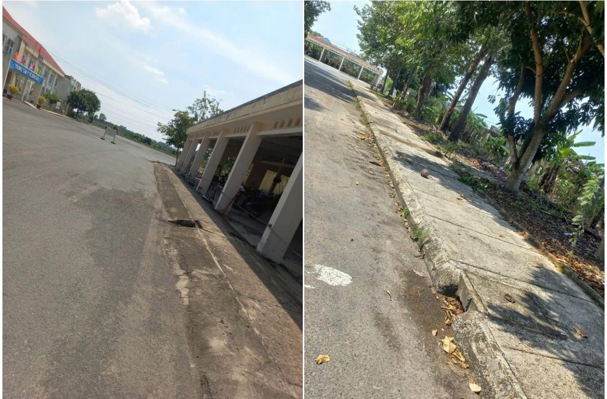
Hình 5. Đường nội bộ, mương thoát nước tại cơ sở
