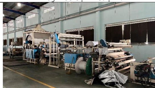
Hệ thống máy cán – cuộn – sấy
