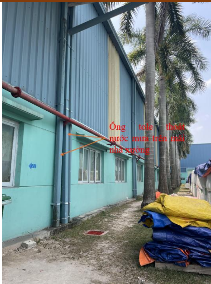
Hình 3. 2. Hình ảnh thoát nước mưa trên mái nhà xưởng
