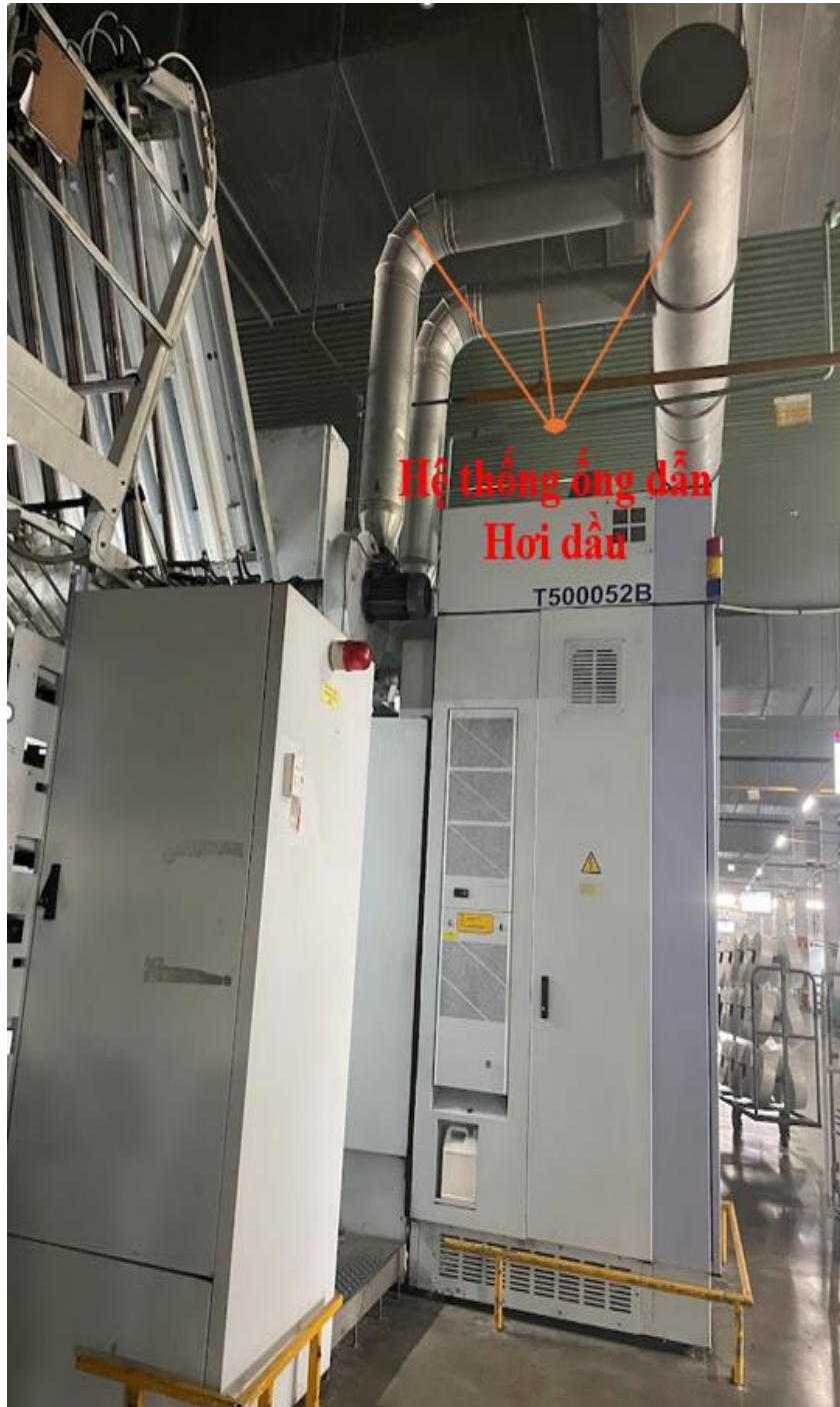
Bảng 3. 23. Hệ thống ống dẫn hơi dầu
