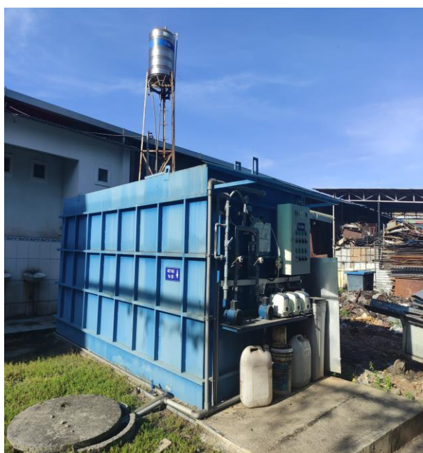
Hình 3. 1. Hệ thống xử lý nước thải sinh hoạt 15 \text{ m}^3/\text{ngày.đêm}
