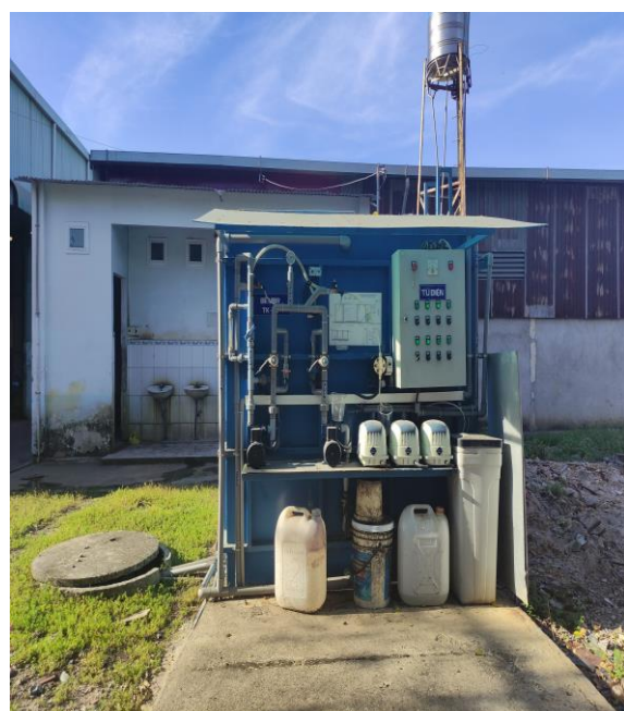
Hình 3. 1. Hệ thống xử lý nước thải sinh hoạt 15 \text{ m}^3/\text{ngày.đêm}
