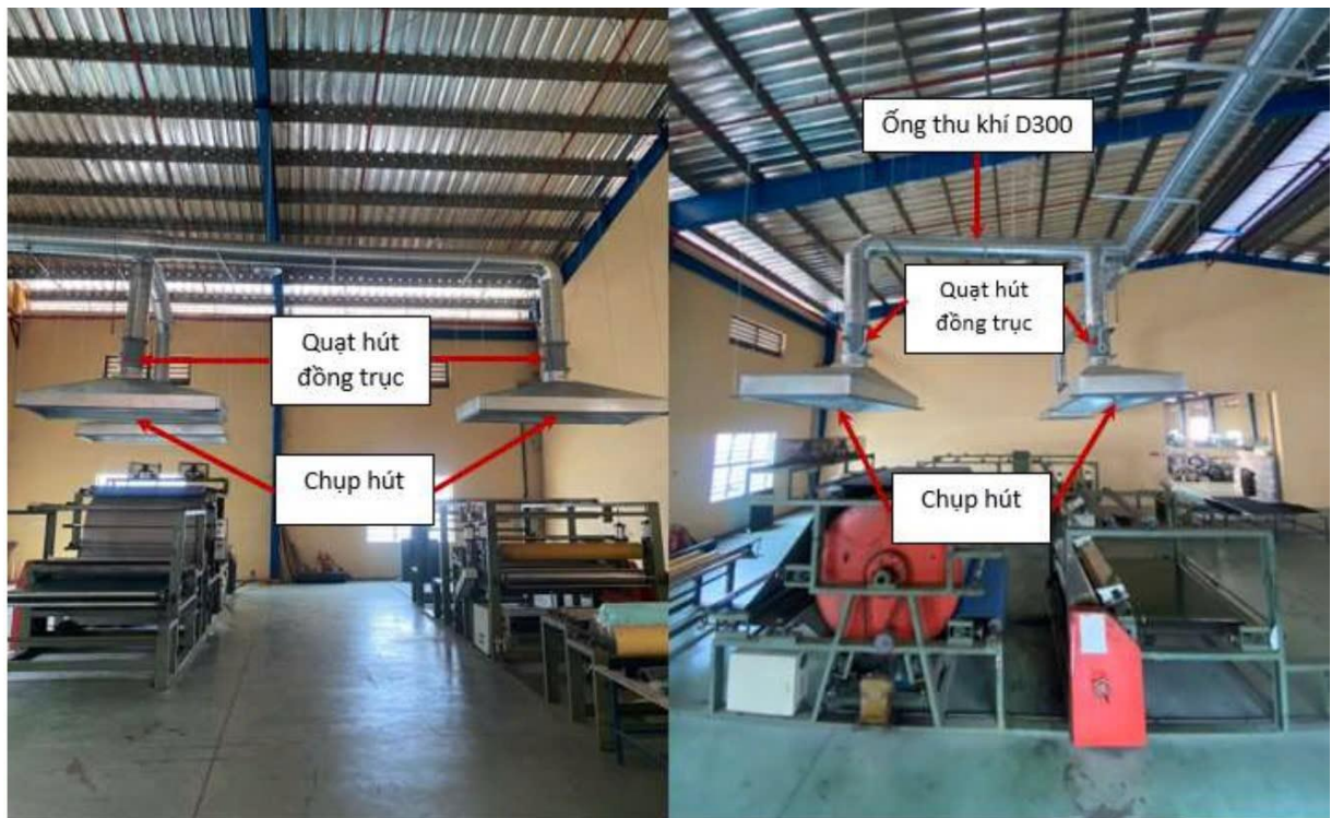
Hình 10 Bố trí thiết bị thực tế bên trong xưởng
