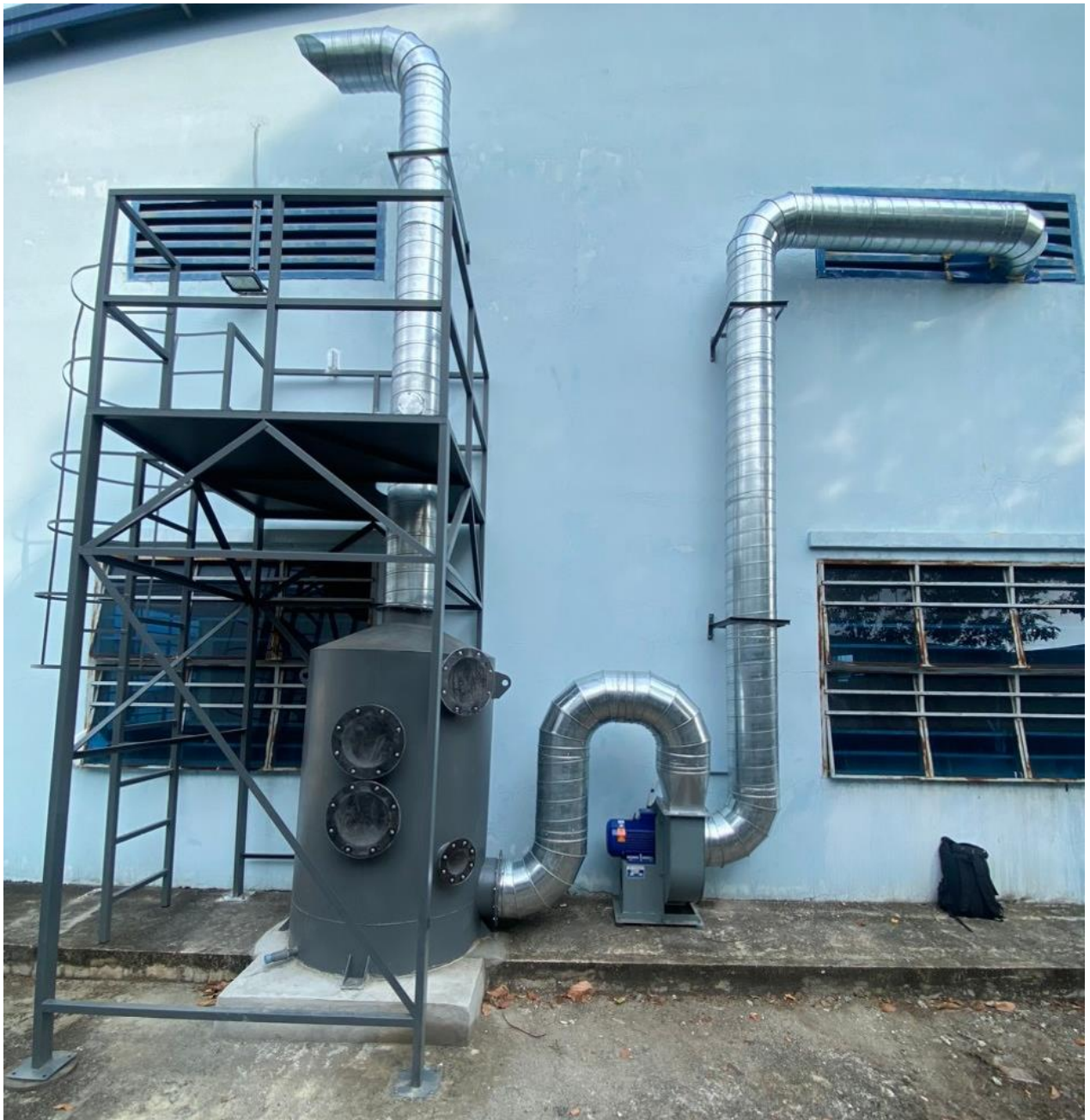
Hình 11 Hình ảnh ống khói và sàn thao tác lấy mẫu
