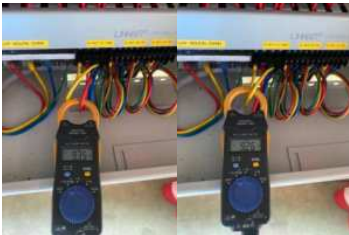
Hình 2.4. Đo dòng điện của thiết bị hoạt động bình thường
