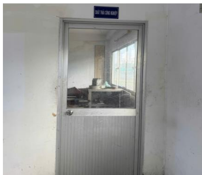
Hình 1.20. Kho chứa chất thải công nghiệp thông thường tại Cơ sở
