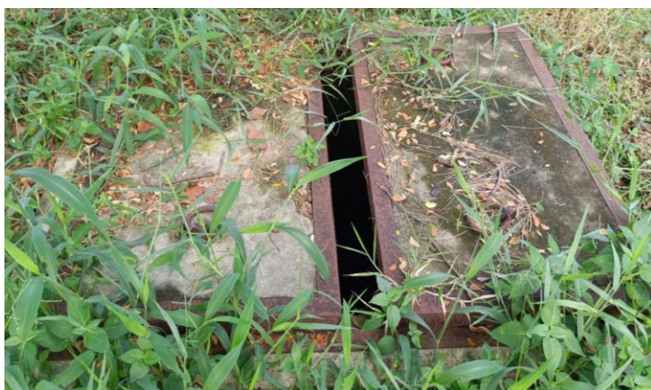
Hình 3.4. Hố ga đầu nối nước thải với KCX và CN Linh Trung III
