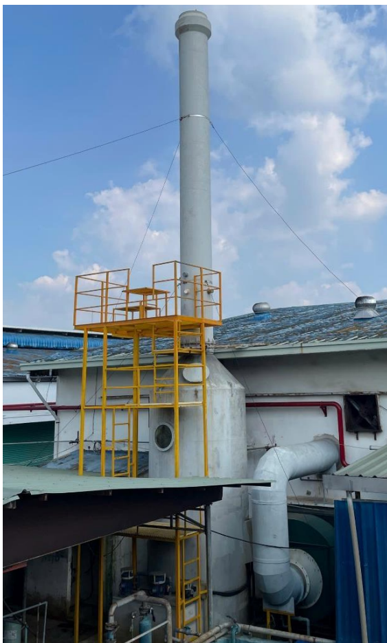
Hình 35. Hình ảnh tháp hấp thụ số 2 và sơ đồ cấu tạo
