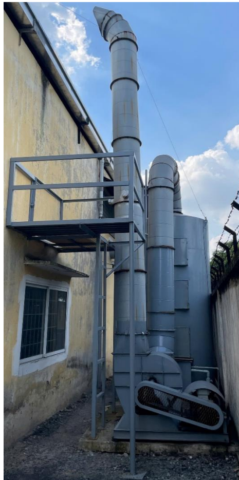
Hình 38. Hình ảnh tháp hấp thụ số 3 và sơ đồ cấu tạo
