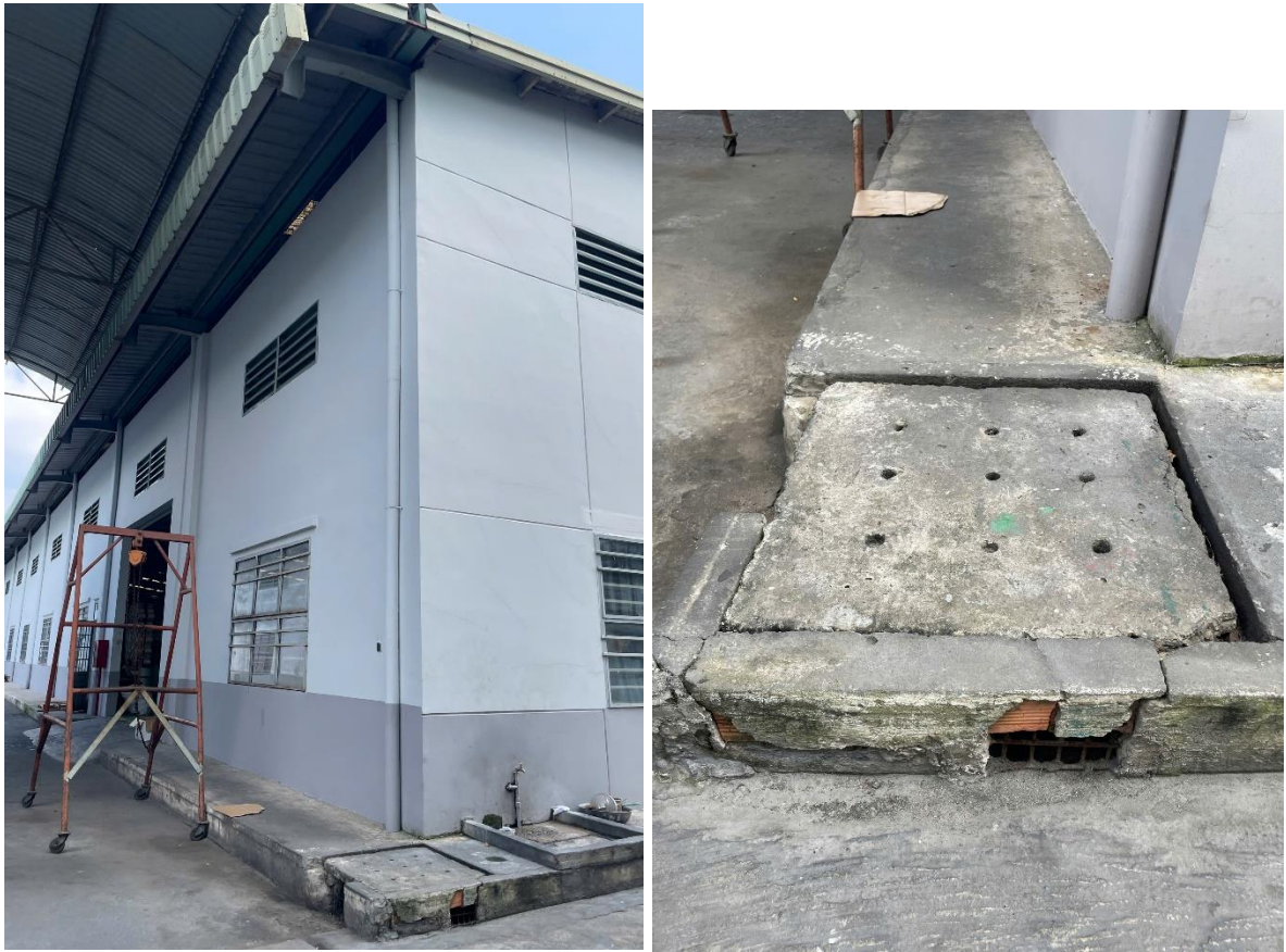
Hình 20. Hình ảnh nước mưa tầng mái (trái); nước mưa chảy tràn (phải) của nhà xưởng 2
