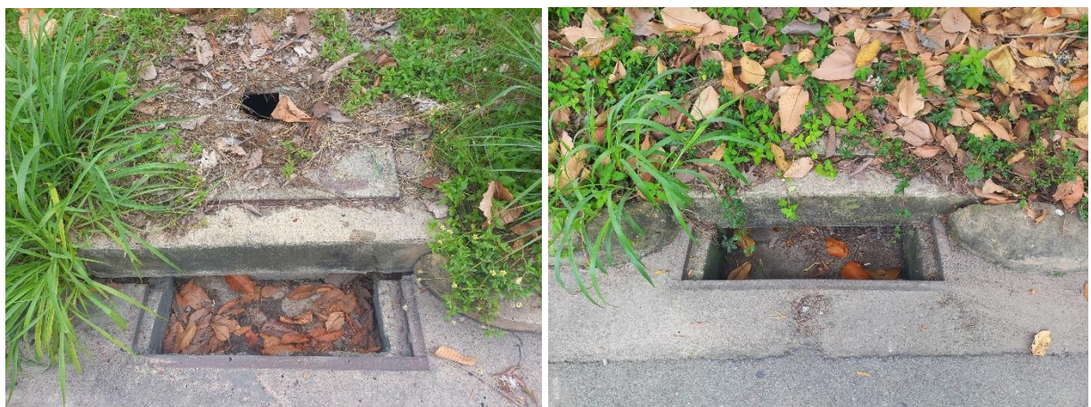
Hình 22. Hình ảnh hố ga đầu nổi nước mưa nhà xưởng 1 (trái), nhà xưởng 2 (phải)
