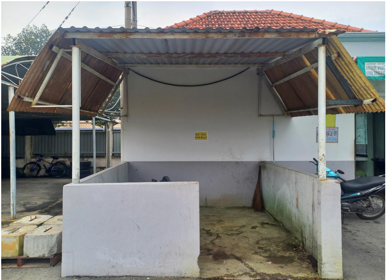
Hình 46. Hình ảnh khu vực tập kết chất thải rắn sinh hoạt
