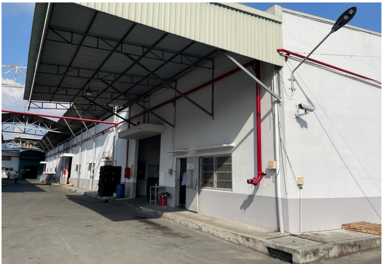
Hình 19. Hình ảnh nước mưa tầng mái và nước mưa chảy tràn của nhà xưởng 1
